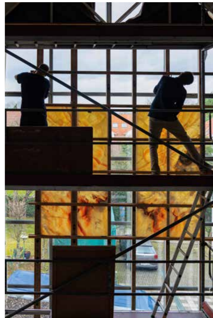
Probeaufbau von zwei Chorfenstern zur finalen Begutachtung und Abnahme in der Werkstatt.
